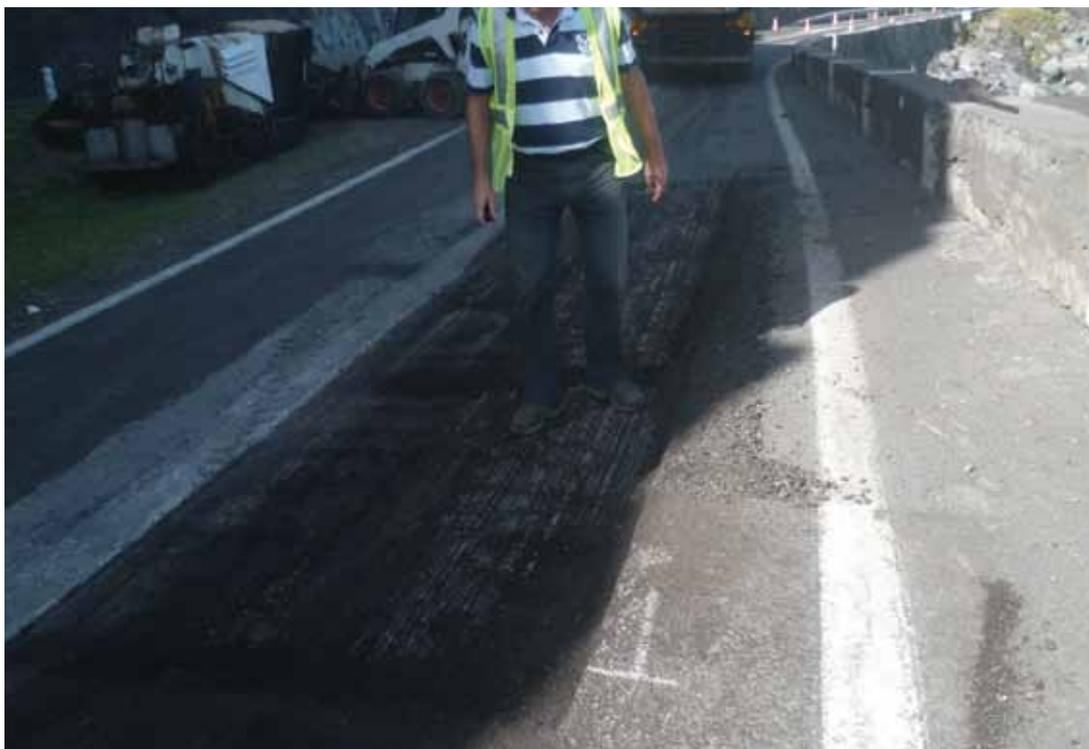
**Figure 16 :** Photo du rabotage d'une partie de la chaussée au Cap la Houssaye (source SBTPC)
