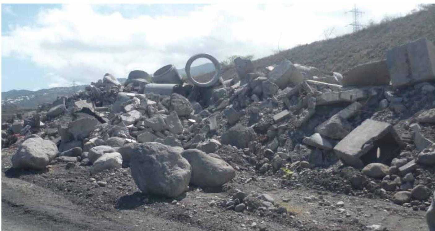
Figure 4 : Matériaux à recycler stockés sur site (source SCPR)
