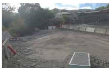
**Figure 12 :** 0/80 utilisé comme couche de forme (source GTOI, chantier ouvrage d'art Bœuf Mort)
