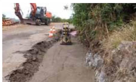
**Figure 11 :** 0/80 utilisé dans le remblayage de tranchée (source EDF, chantier STEP du PORT)
